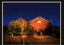
遠賀川水源地ポンプ室 [福岡県・中間市]
