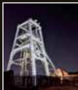
三池炭鉱 宮原坑 [福岡県・大牟田市]
